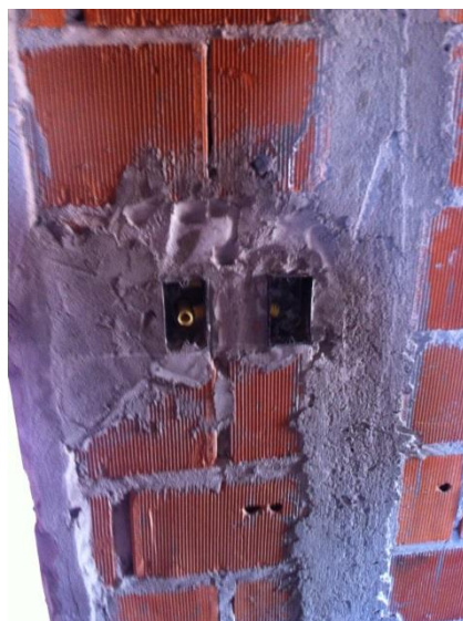
Foto 04: blocos cortados somente após assentamento para fixação de caixas.
