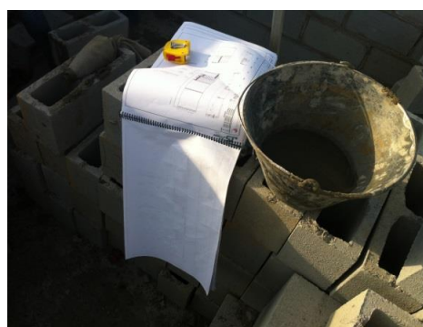
Foto 06: Projetos disponíveis no local da obra
