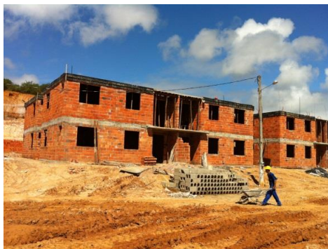
Foto 05: Vista geral da obra
