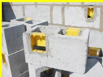
Cortar previamente os blocos que apresentam caixas elétricas
