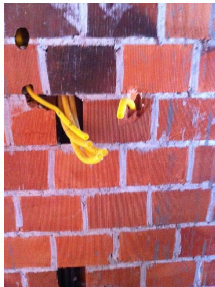
Foto 04: blocos cortados somente após assentamento para fixação de caixas.
