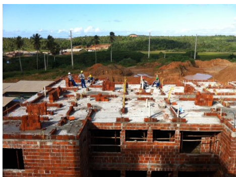
Foto 01: vista geral pavimento
