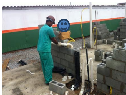
Foto 10: funionário colocando kit de tubulação previamente montado na alvenaria
