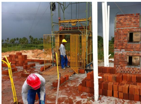
Foto 07: funcionários terceirizados descarregando blocos no pavimento
