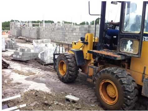
Foto 03: 2 carregadeira utilizada para o transporte de blocos
