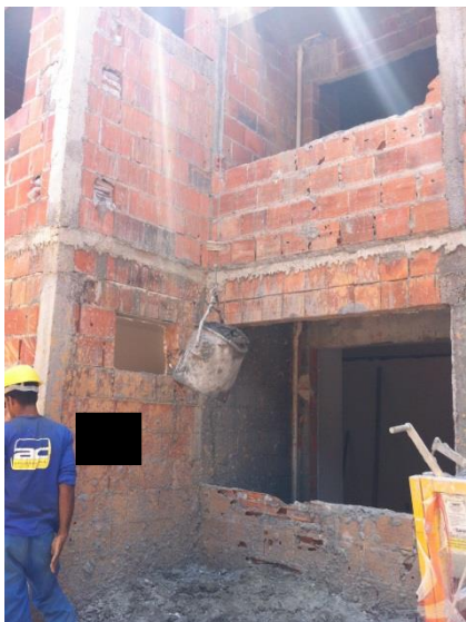
Foto 03: Foguetinho (transporte de argamassa: carrinho de mão ⇒ foguetinho ⇒ pavimento)
