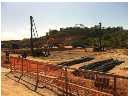
Foto 01: Vista geral da obra.
