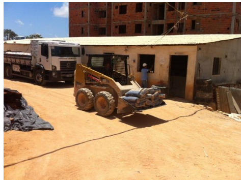
Foto 33: Bob Cat utilizada no transporte de materiais.
