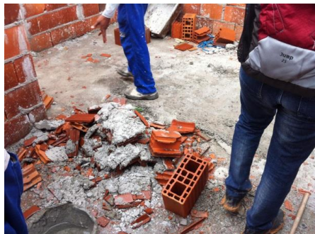
Foto 04: sujeira no pavimento / desperdício de blocos
