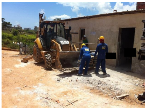
Foto 01: Retroescavadeira utilizada no transporte de blocos
