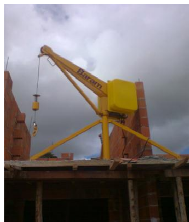
Foto 04: Equipamento foguetinho
