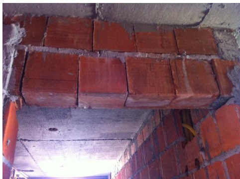
Foto 11: blocos calha para verga de porta
