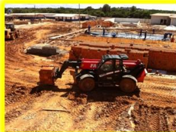
Utilizar manipulador telescópico ou equipamento similar
