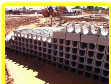
Fornecer os blocos calha prontos para assentamento
