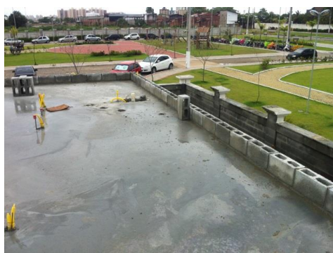
Foto 19: a equipe inicia a alvenaria pelas paredes da periferia (medida de proteção coletiva).
