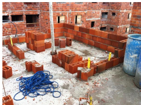
Foto 04: sujeira no pavimento / desperdício de blocos
