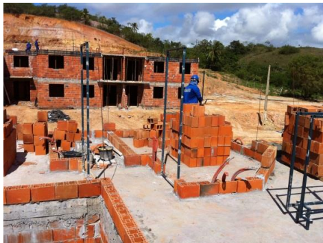
Foto 06: Pavimento de trabalho
