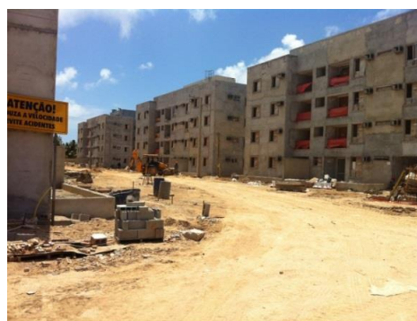
Foto 16: Vista geral da obra. Ao fundo, uma retroescavadeira trabalhando na limpeza do canteiro. Vias de acesso desobstruídas facilitando o acesso das retos e dos manipuladores. Obra limpa e organizada.
