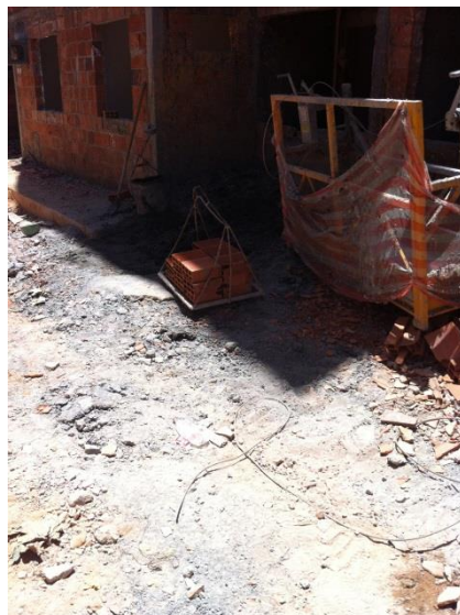
Foto 24: Blocos subindo através de foguetinho (pequena quantidade por subida).
