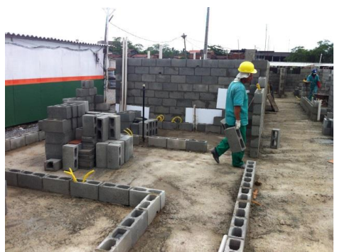
Foto 05: 1ª fiada e eletrodutos. Blocos armazenados para aplicação
