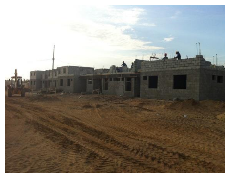
Foto 04: Vista geral da obra
