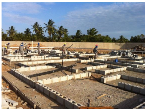
Foto 03: Execução da primeira fiada
