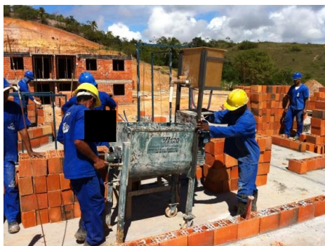
Foto 01: Argamassadeiras no pavimento
