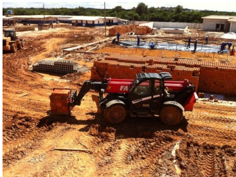
Foto 02: Manipulador telescópico com blocos
