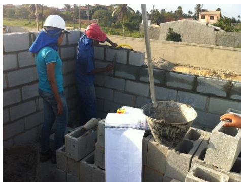
Foto 05: Funcionário elevando parede e técnica acompanhando atividade
