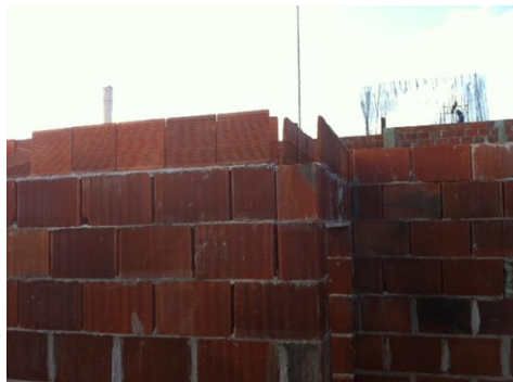
Foto 02: blocos-calha e cerâmicos assentados
