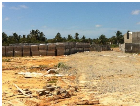
Foto 15: Terreno vizinho com blocos palletizados e vias de acesso do manipulador
