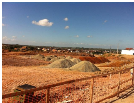
Foto 02: Vista geral da obra.
