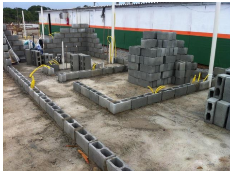
Foto 05: 1ª fiada e eletrodutos. Blocos armazenados para aplicação
