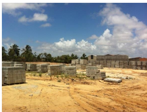
Foto 17: Local de armazenagem dos blocos palletizados.
