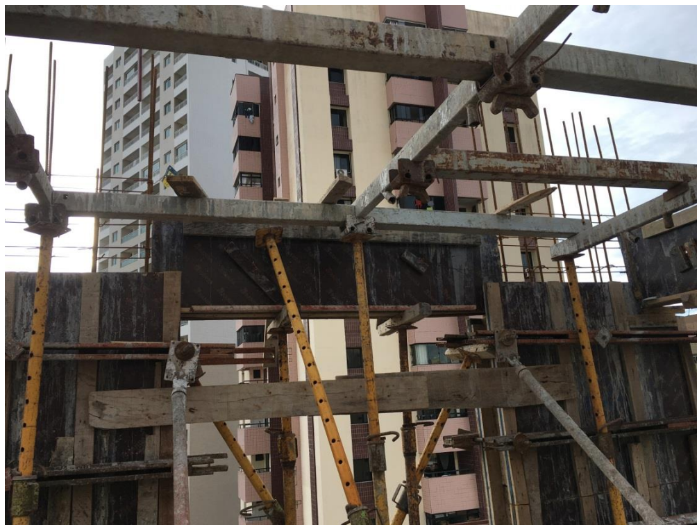
Figura 40 – Início da montagem do cimbramento.
