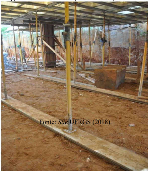
Figura 19 – Escoras apoiadas em pranchões.
