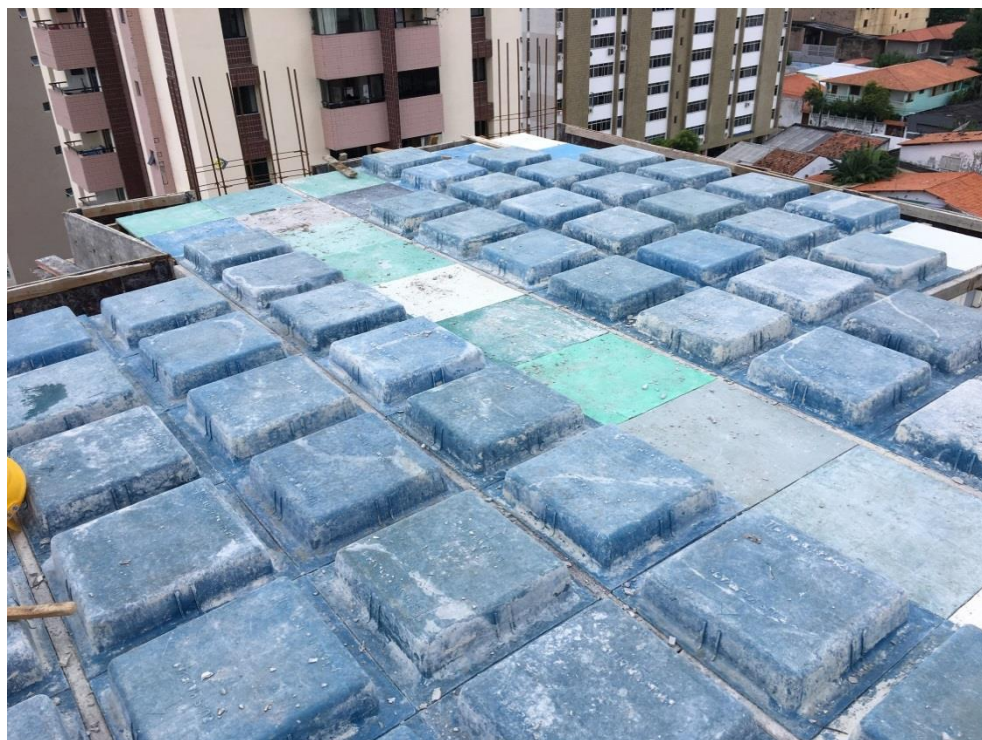
Figura 42 – Montagem das fôrmas.
