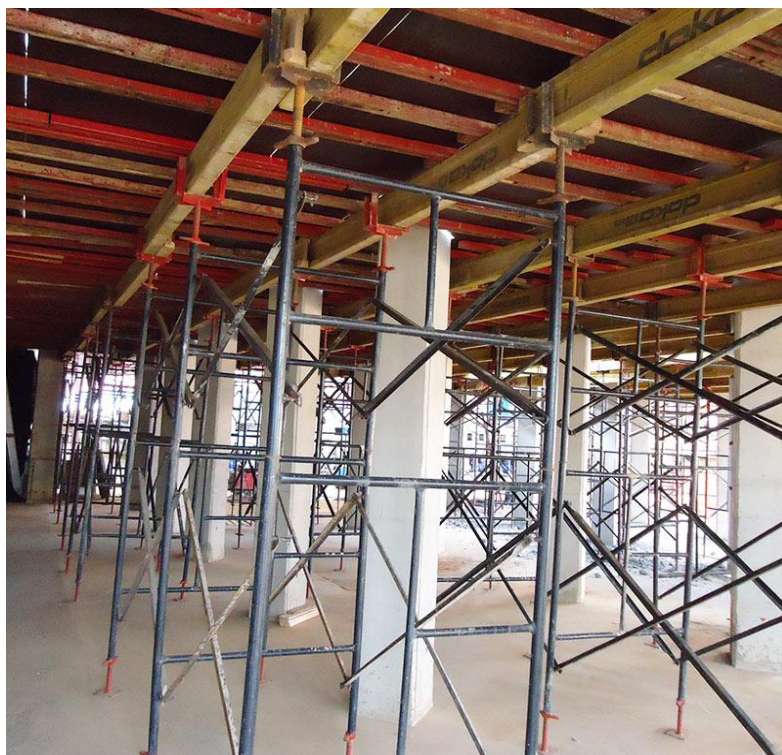
Figura 13 – Torres metálicas.
