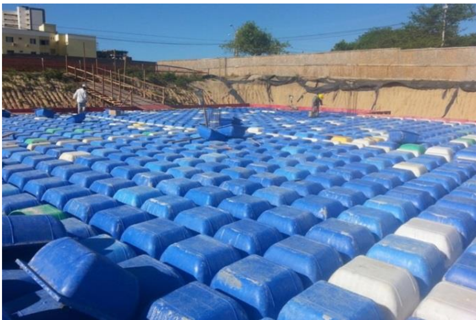
Figura 9 – Laje nervurada com cubetas de polipropileno.
