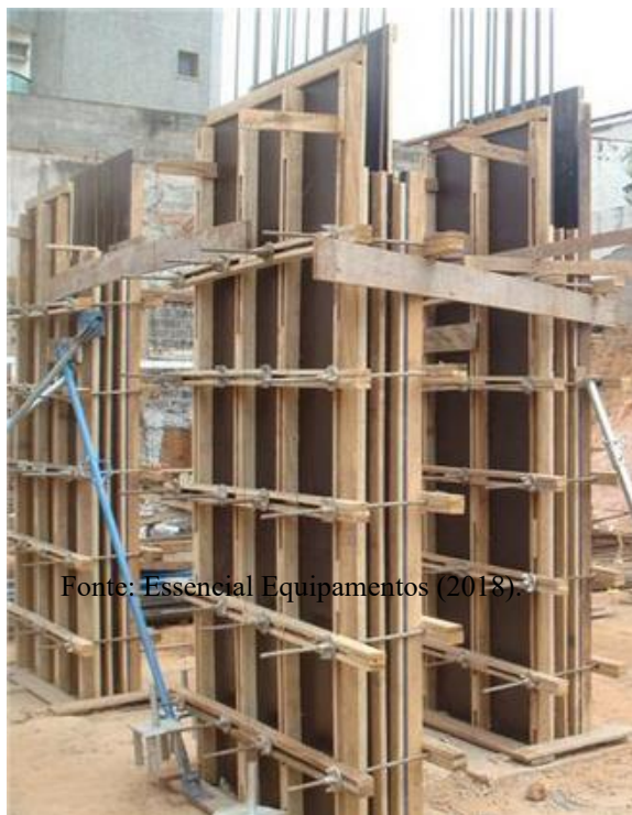
Figura 18 – Montagem de fôrmas de vigas
