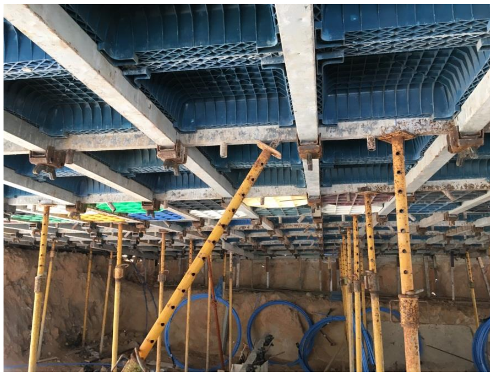
Figura 3 – Cimbramento de uma laje.
