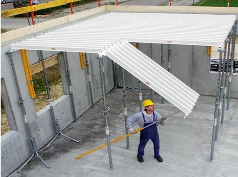
Figura 7 – Fôrmas e escoramentos metálicos.
