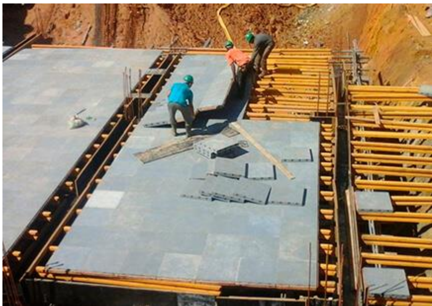
Figura 8 – Fôrmas para laje maciça.
