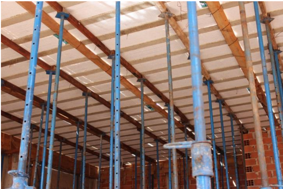
Figura 12 – Escoras metálicas tubulares.
