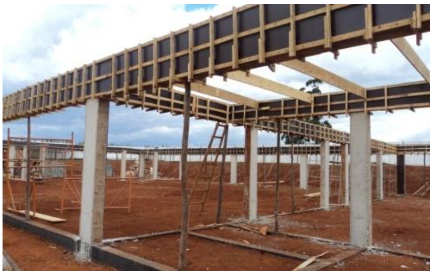
Figura 18 – Montagem de fôrmas de vigas
