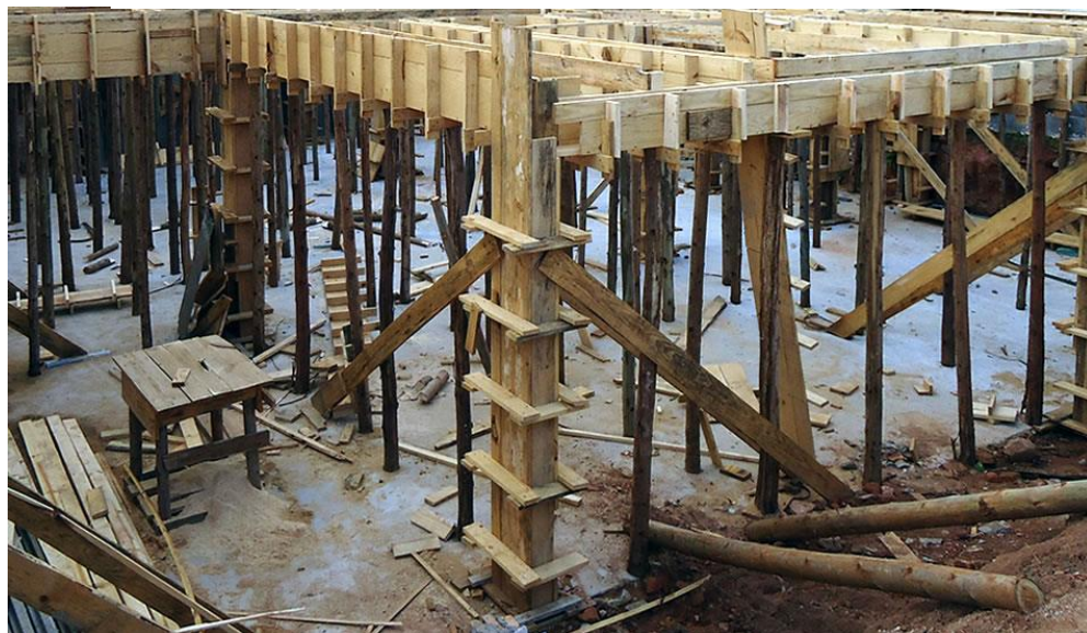
Figura 11 – Cimbramento e escoramento em madeira.
