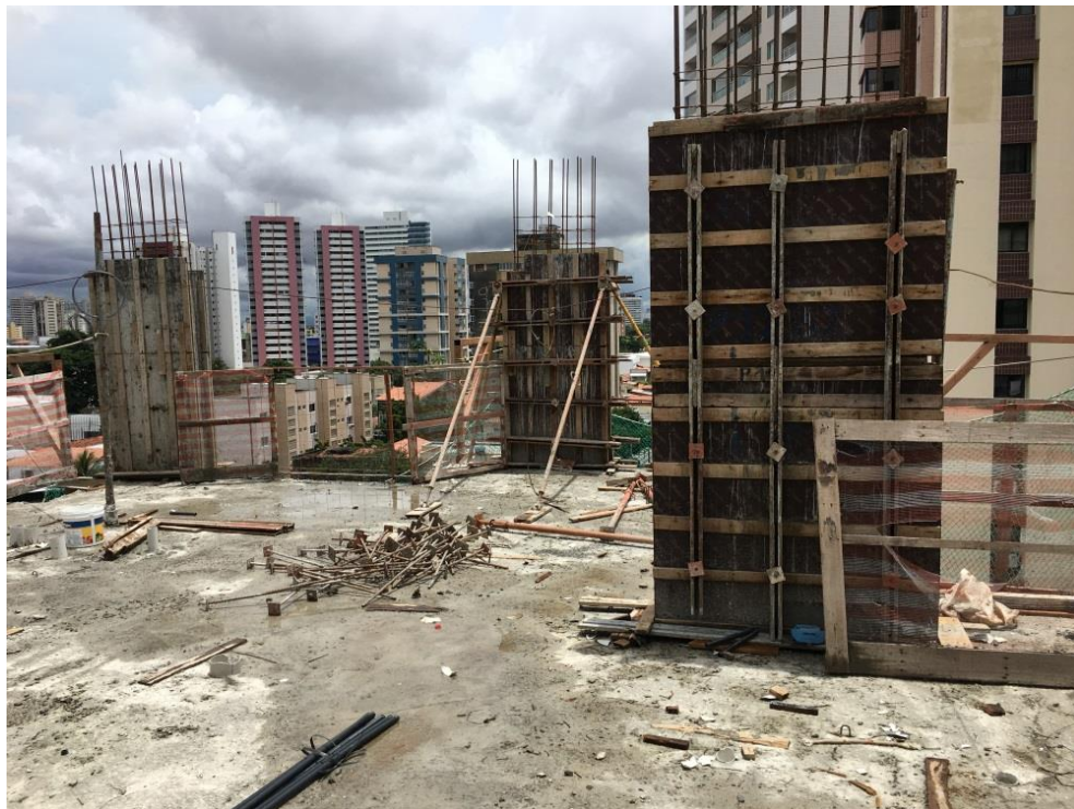
Figura 38 – Montagem de fôrmas de pilares.
