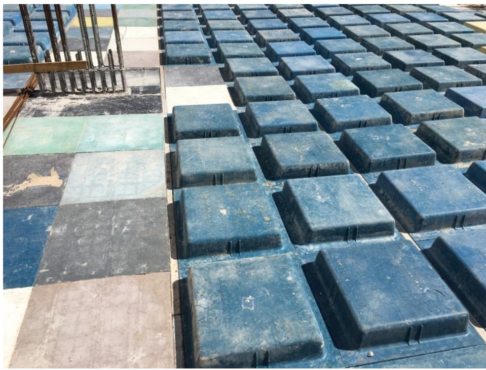
Figura 2 – Molde (fôrma) de uma laje.
